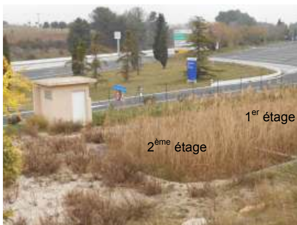
Station de traitement par filtre planté de roseaux (Engéo, 2016)
