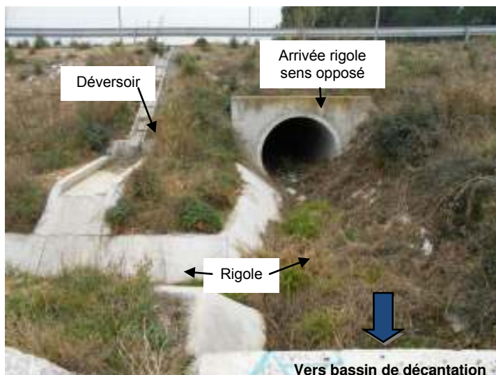
Photo illustrant le déversoir et l'arrivée des eaux récupérées par l'autre voie d'autoroute (Engéo, 2016)
